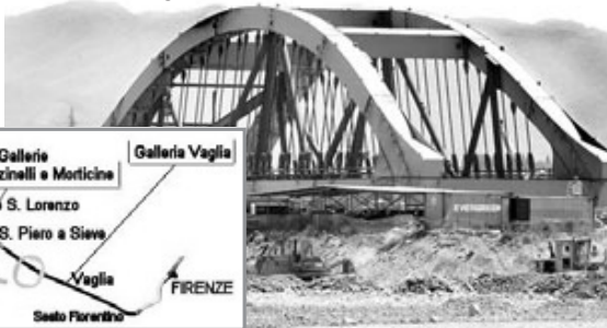
I LAVORI PER LA TAV NEL MUGELLO. IN ALTO IL PERCORSO DELL'ALTA VELOCITÀ DA FIRENZE A BOLOGNA
